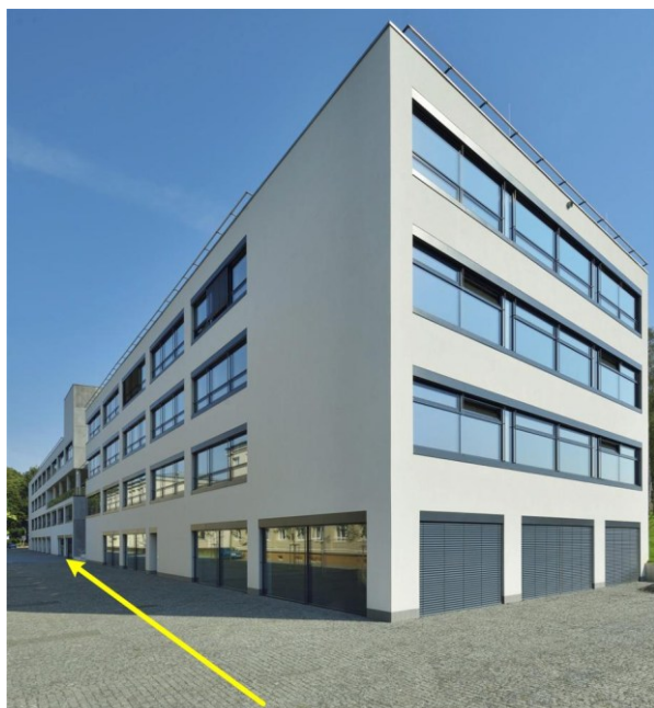
Obr. 21: Budova G TULky při pohledu od schodiště
