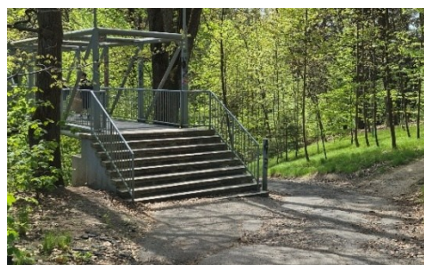
Obr. 27: Ocelová lávka na stezce pro pěší
