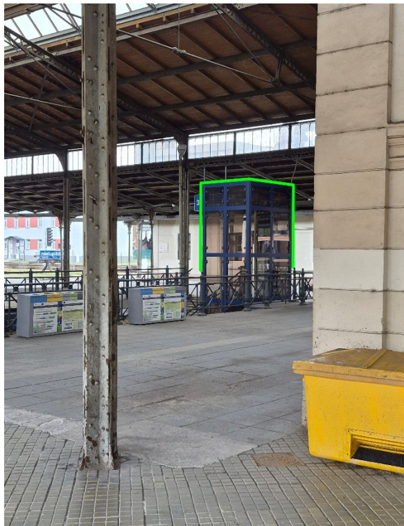
Obr. 14: ... dokud nedojdete za jižní roh budovy
