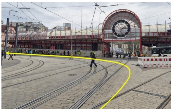
Obr. 19: Terminál MHD Fügnerova – čelní pohled
