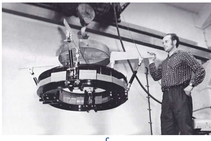
Obr. 7: Kyvadlový pohlcovač kmitání stožáru za větru: a) Schéma závaží pro vyvažování kmitání, zeleně zvýrazněny šikmo zavěšené automobilové tlumiče a modře závaží, které bylo možno podle potřeby různě přikládat na sebe, aby bylo možné během provozních testů a i později podle potřeby soustavu kyvadlo-stožár vysílače dobře vyladit. (BERAN et al. [4]) b) Fotografie hotového kyvadla v jehož dolní polovině jsou dobře vidět různě na sebe poskládaná jednotlivá závaží jejichž lože je pomocí 4 automobilových tlumičů na konstrukci pomocí níž se kyvadlo zavěšovalo. Kruhovú konstrukci s otevřeným středem byla nutná proto, aby bylo možné skrz kyvadlo prolézt do stožáru vysílače, který byl opatřen žebříkem pro přístup k jednotlivým anténám a výstražným majákům na jeho vrcholu (JIROUTEK [9]). c) Autor kyvadla, statik stavby Ing. Zdeněk Patrman při laboratorních zkouškách kyvadla (JIROUTEK [9]). d) Pohled zdola na kyvadlo zavěšené na patě válcovité části anténního stožáru (JIROUTEK [9]).
